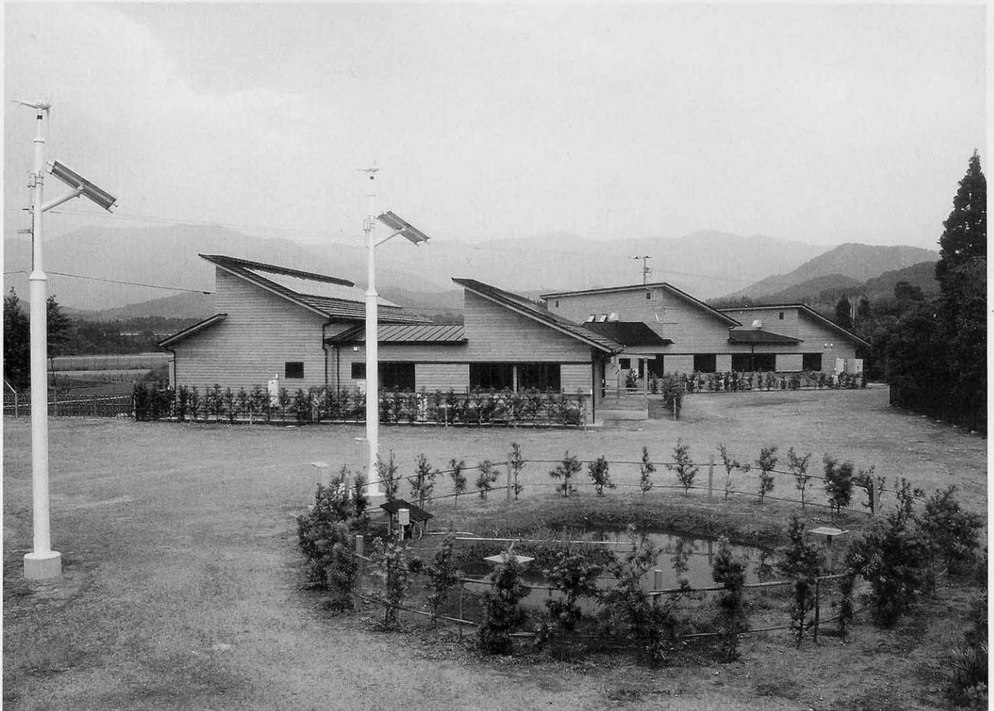
西側庭の池越しに見る全景。人工的に設けたビオトープの水の循環設備の電源として利用する、ハイブリッド型風力発電システムの風車が立っている。
