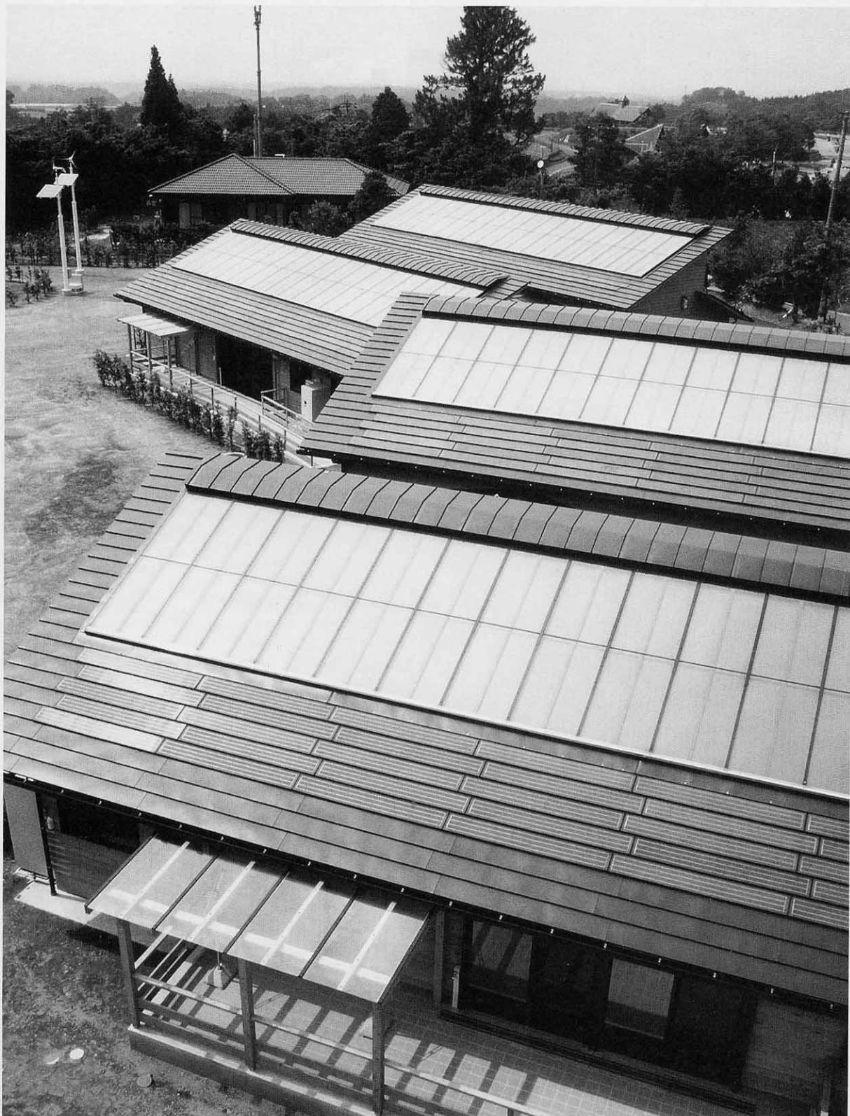
南側から、手前にA棟、奥にB棟屋根のOMソーラーシステムの集熱面を見下ろす。認知症グループホーム2ユニットを2棟に配置、地域と交流できるような建物としている。
