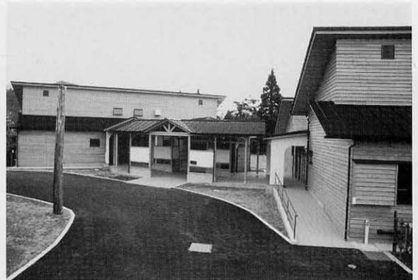
2棟の入口を見る。外壁は地元の杉材を使ったドイツ下見板張りの木造平屋建て。
