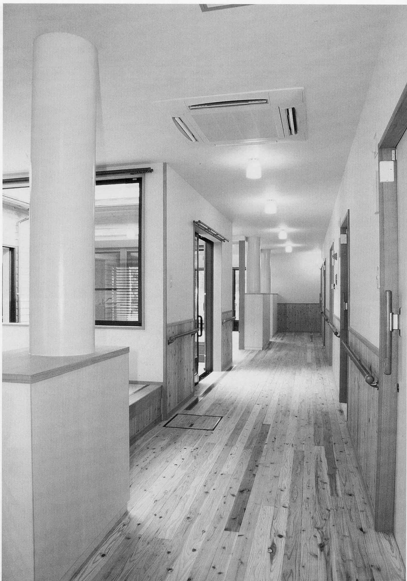
A棟の玄関ホールから居室前の廊下を見る。廊下の左側にOMソーラーシステムの立下がりダクトが3本見える。
